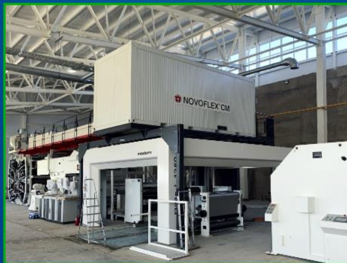
2019 год, монтаж оборудования
